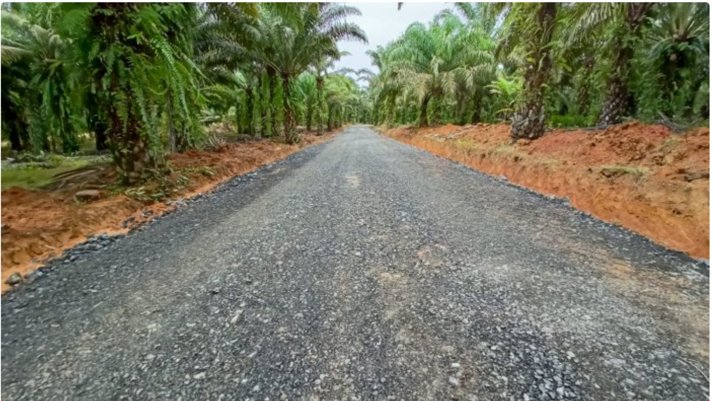
Sasaran TMMD Ke 116 Kodim 1004/Kotabaru Rampung 100 Persen
